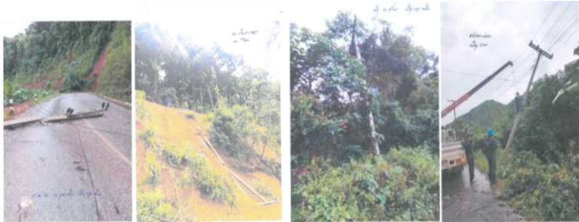
ຮູບພາບ 45: ຕາຂ່າຍໄຟຟ້າ ທີ່ໄດ້ຮັບຄວາມເສຍຫາຍ. ທີ່ມາຂອງຮູບ: ບໍລິສັດໄຟຟ້າລາວ
